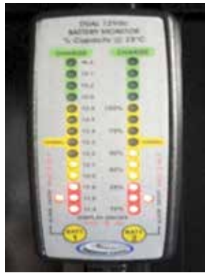
Figura N° 17: Supervisión de carga de baterías.
