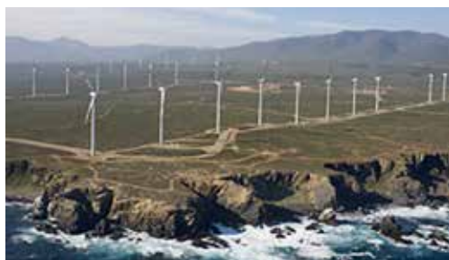
Figura N° 3: Parque Eólico Canela. Región de Coquimbo.
